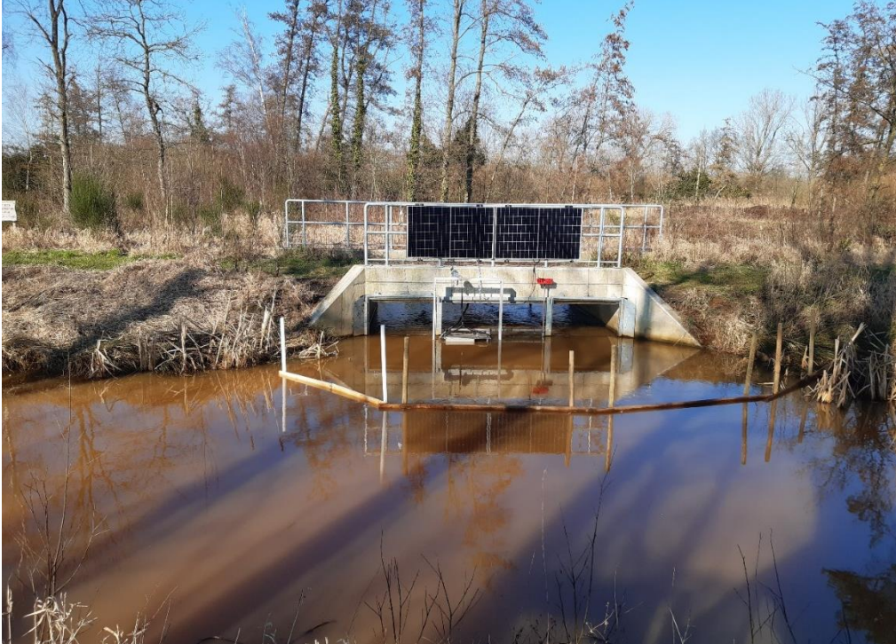
Figuur 39: Initiële opstelling, nog zonder zonnesherm en met enkele drijfbalk. © Mechtild Zoeter Vanpoucke, PCM.
