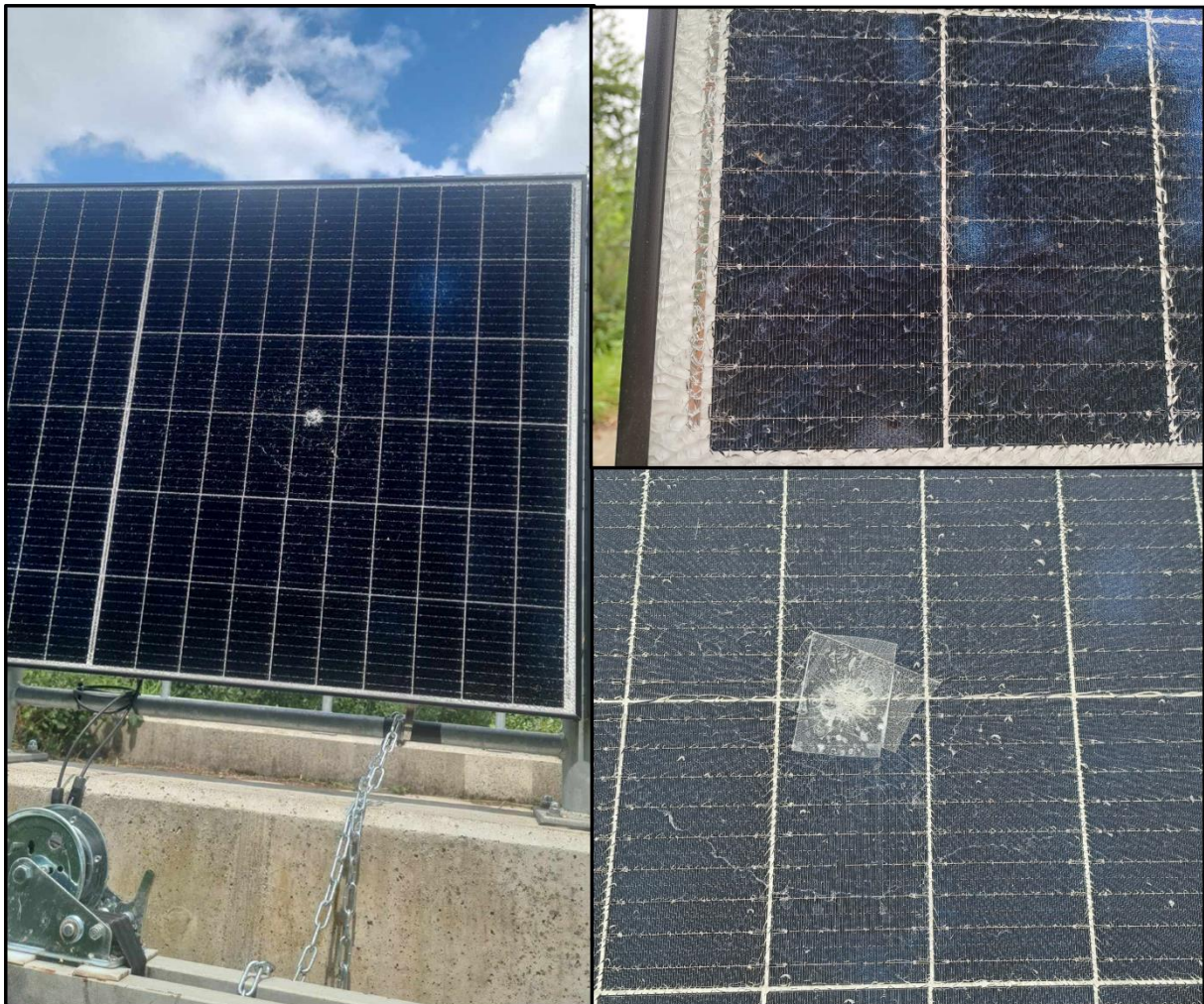
Figuur 12: Beschadigd zonnepaneel. Links: overzichtsfoto. Rechts detailfoto's waarop het verbrijzelde glas duidelijk zichtbaar is en op de onderste foto de transparante tape die als doel had het risico op insijpelend vocht te beperken. ©Mechtild Zoeter Vanpoucke.
