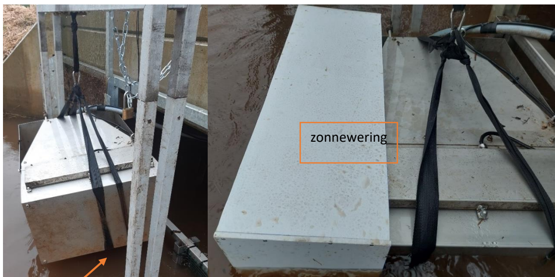
Figuur 42: Links: omhooggetakelde camerabox die schuin hangt omdat de voorste draagriem naar achter is geschoven (oranje pijl). Rechts: neergelaten box met draagriem op correcte locatie en zonnewering over de box geplaatst. © Mechtild Zoeter Vanpoucke, PCM.
