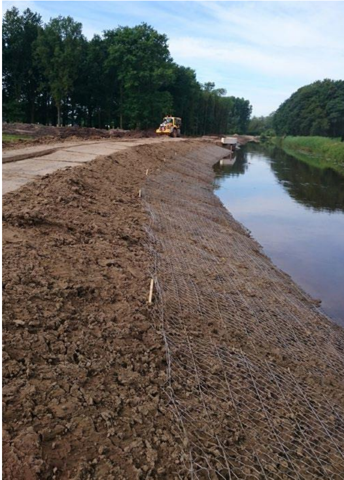
Figuur 2.2.9: Gaas aangebracht langs een oever langs de Dommel, voor het aanbrengen van de afdeklaag (Bron: Waterschap De Dommel).
