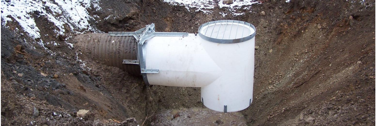
Figuur 2.2.23: Hetzelfde T-vormige verlengstuk als op figuur 2.2.22 in droge toestand. Bemerkt hoe diep de instroomopening zit (Bron: https://www.beaverproofaddon.com ).
