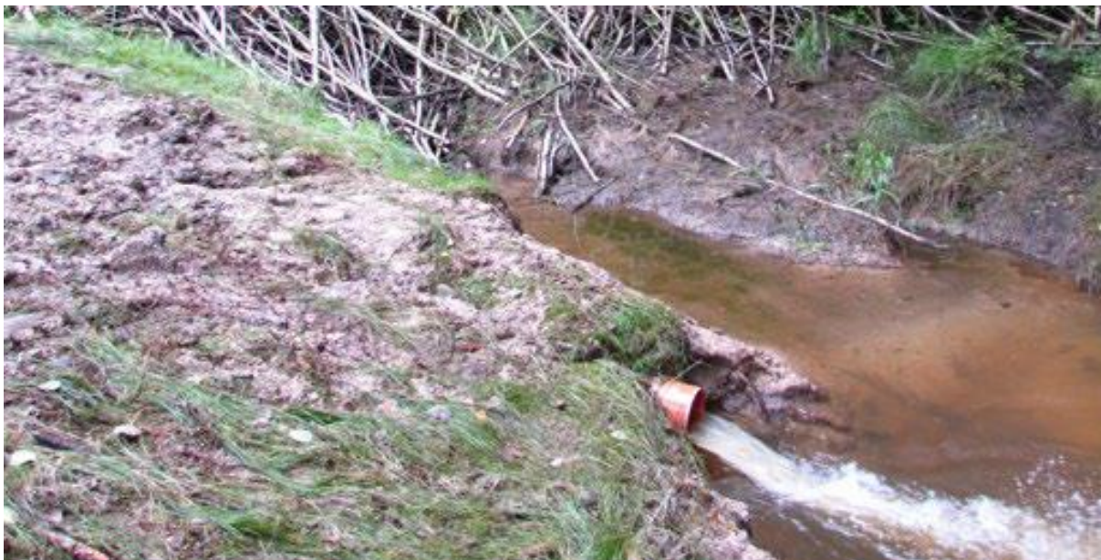
Figuur 2.2.31: Uitstroom opening van een 'Beaver deceiver' naast een beverdam, zie ook figuur 2.2.30. Zo kon de instroom en de uitstroom verder van de dam worden gesitueerd en was (nog) geen filter bij de instroom opening noodzakelijk (R. Campbell-Parker).
