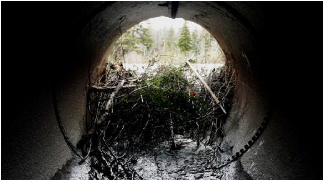
Figuur 2.2.18: Bevers stoppen een duiker deels dicht met takken, vegetatie en modder om een hogere waterstand te verkrijgen (S. Lisle).
