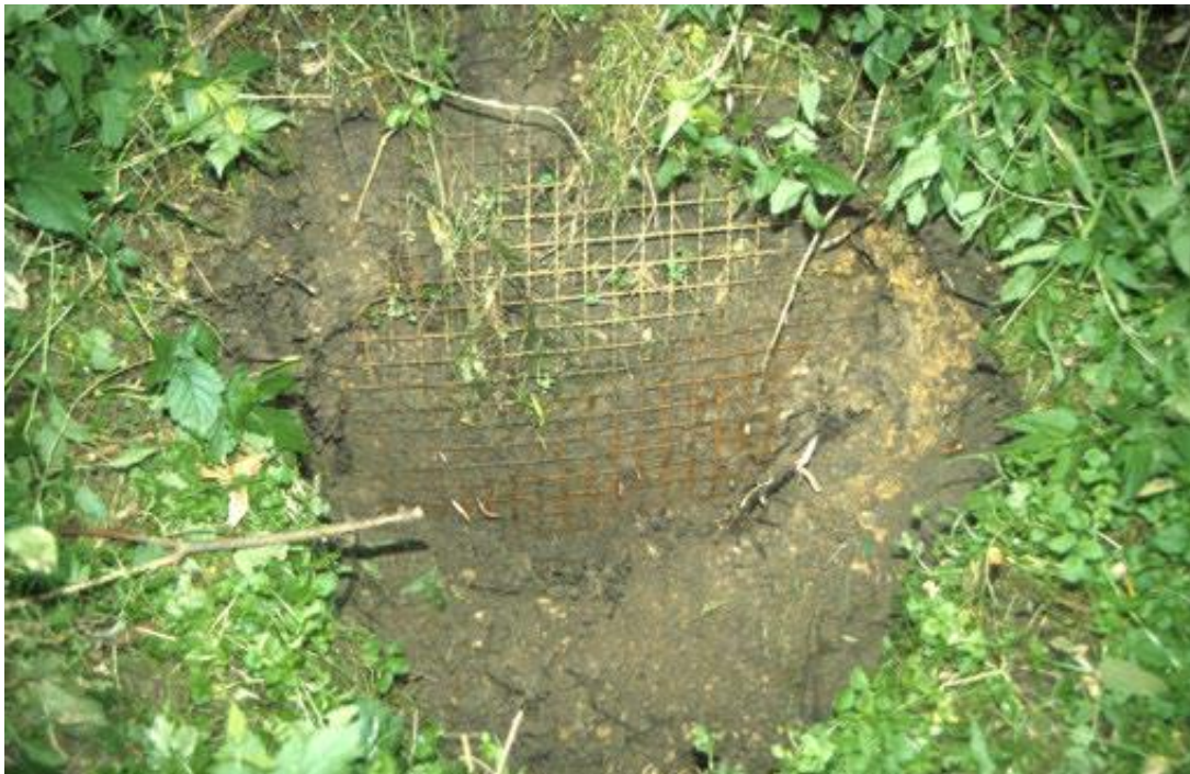
Figuur 2.3.3: Gaas in de grond om te voorkomen dat bevers (verder) graven. Om te voorkomen dat door roest het gaas relatief snel vergaat, kan gekozen voor roestvrij staal, al is dat een duurdere optie (G. Schwab).
