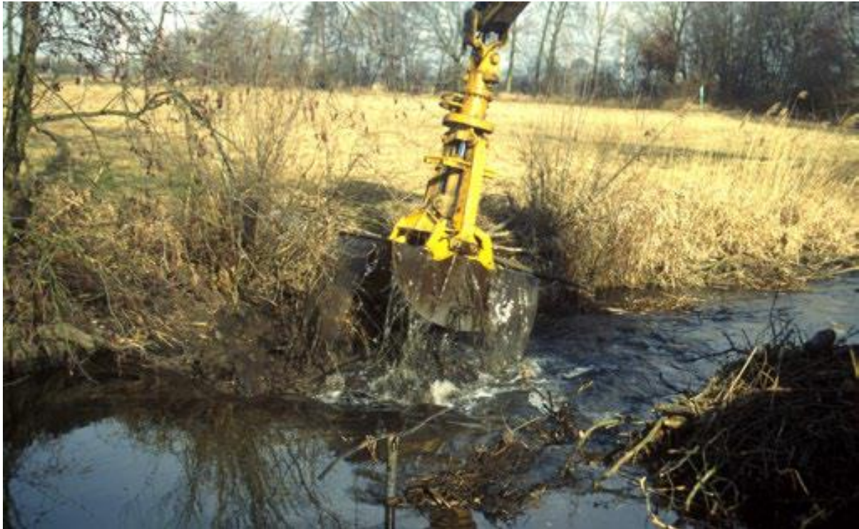
Figuur 2.3.1. Verwijderen van een dam met een kraan (G. Schwab).
