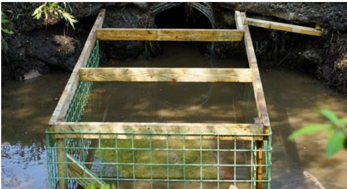
Figuur 2.2.19: Kooi met gaas voor een duiker om te voorkomen dat een bever de duiker dichtstopt met takken en modder (S. Lisle).
