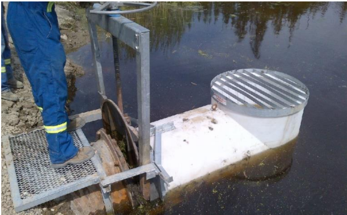
Figuur 2.2.22: Een T-vormig verlengstuk op de overloopbuis, waarbij een schuif werd ingebouwd om het peil te kunnen regelen (Bron: https://www.beaverproofaddon.com ).
