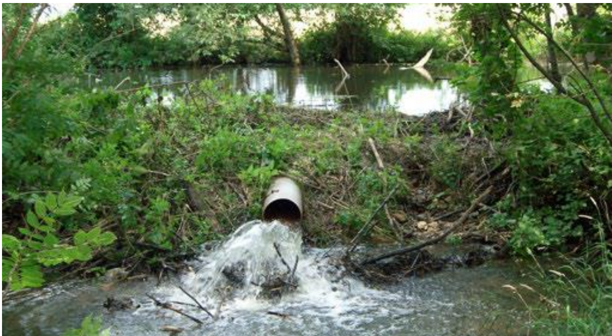
Figuur 2.2.28: Beverdam met een 'Beaver deceiver'. In dit geval zonder filter bij de instroom opening. Ook dat kan soms goed functioneren (G. Schwab). De uitstroomopening bevindt zich niet onder water waardoor in dit geval de bever het lek snel kan detecteren.
