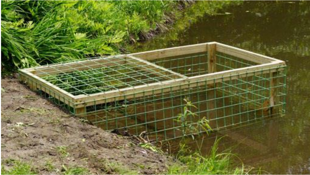
Figuur 2.2.20: Kooi met gaas voor een duiker om te voorkomen dat een bever deze dichtstopt met takken en modder (S. Lisle). Aan de kant van de oever is de bovenkant dicht om te voorkomen dat de bevers van bovenaf materiaal inbrengen.
