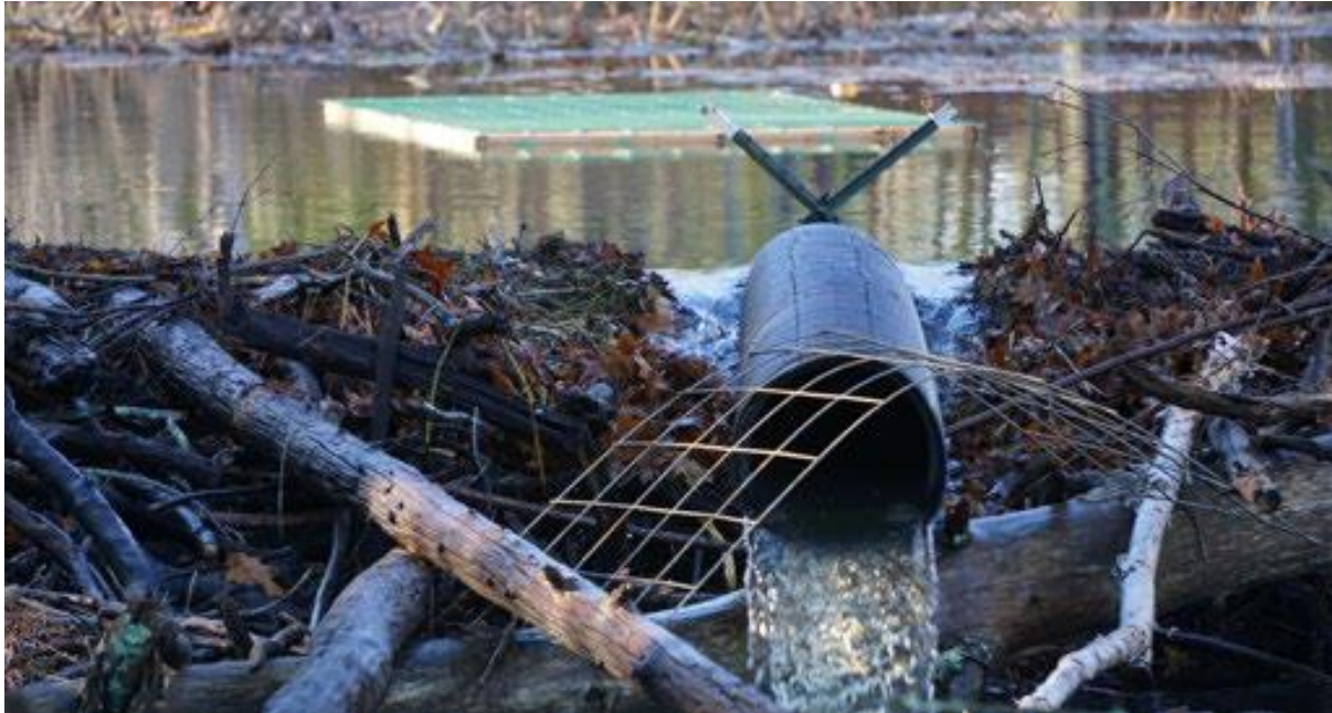
Figuur 2.2.32: Beverdam met een 'Beaver deceiver' in de vorm van een dubbelwandige PE buis. Op de achtergrond is de filter van de instroom opening te zien. Op de voorgrond het gebogen gaas dat de bevers bij de uitstroomopening weghoudt. Met een stalen kruis wordt de buis op zijn locatie gehouden (S. Lisle).
