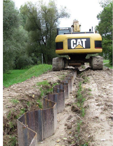
Figuur 2.2.14: Damwanden die in de oever zijn geplaatst om graafschade te voorkomen (R. Campbell-Palmer).
