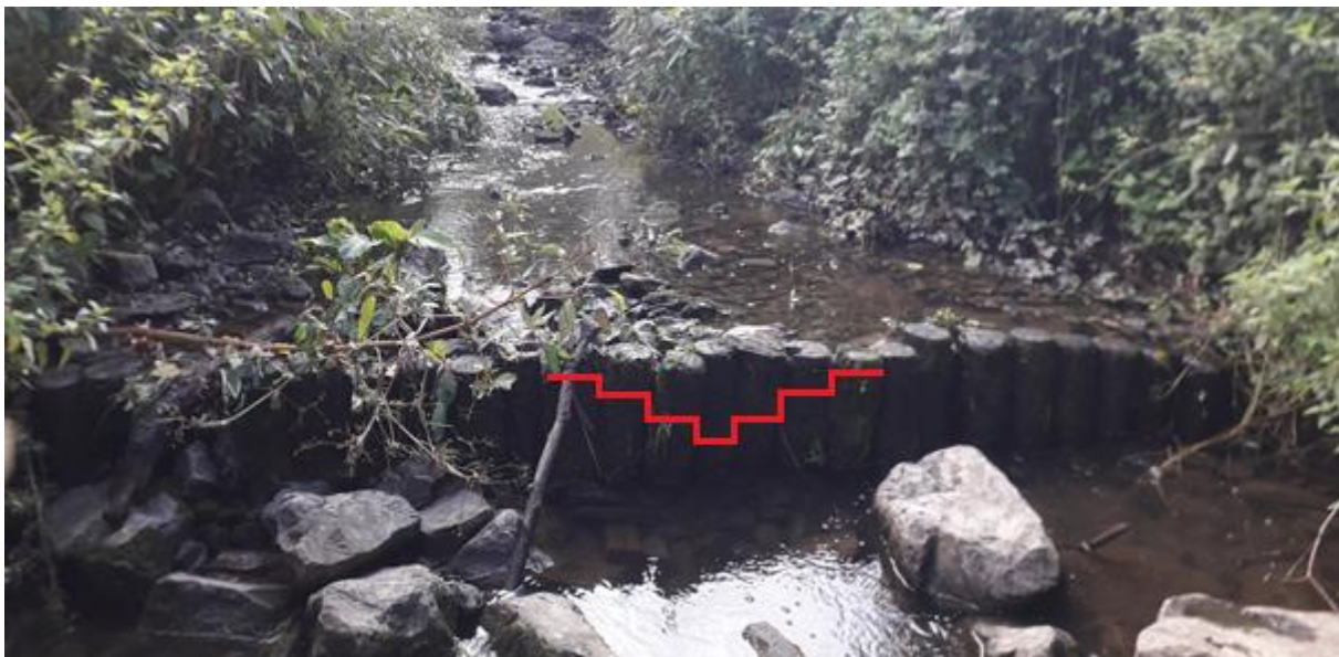
Figuur 14: Palenrij ter hoogte van de oude watermolen in de Ruststraat (Erpe-Mere) die fungeert als duidelijk vismigratieknelpunt en illustratie (rode lijn) hoe palenrij (in combinatie met wat steenbestorting) zou kunnen worden aangepakt in eerste instantie om dit te proberen verhelpen.
