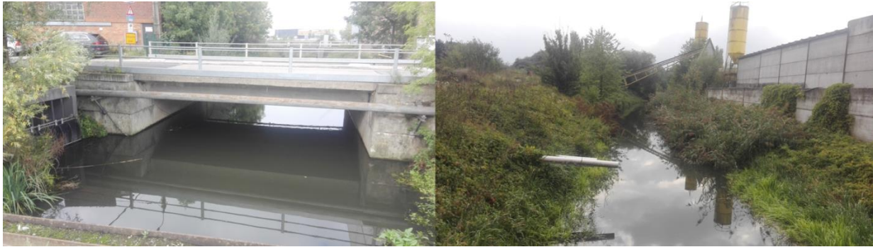
Figuur 12: Zicht op de Gaverbeek aan locatie 475. LINKS: zicht op monding in de Leie, net stroomaf van locatie 475. RECHTS: Zicht op een deel van het afgeviste traject aan locatie 475.
