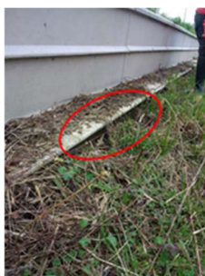
Slechte aansluiting amfibieënwand op ondergrond
