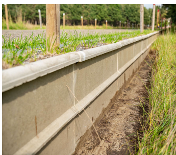
Vrij loopvlak boven- en onderaan amfibieënwand
