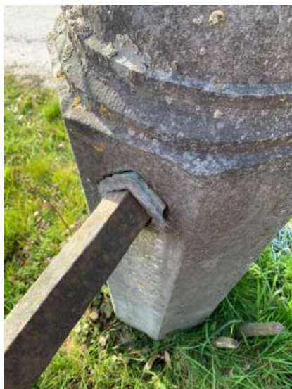
Detail van de losgekomen verbinding (22.04.2021, Erfgoed en Visie)
