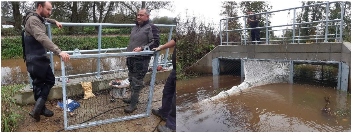
Figuur 4: Inspectie van de zijframes en finale installatie van de frame/fuik constructie.
