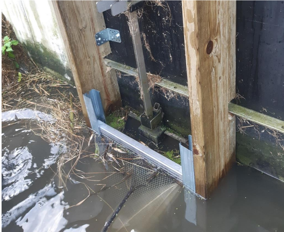
Figuur 3 – Foto van de fuikconstructie aan het Geleed Noord. De houten balk zorgt ervoor dat de volledige opening wordt afgesloten zodat vissen enkel in de fuik kunnen zwemmen.
