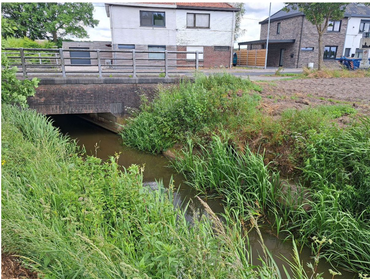
Figuur 2 – Foto's van locaties van stroomafwaarts naar stroomopwaarts die onderzocht werden in het onderzoek van 2025.
