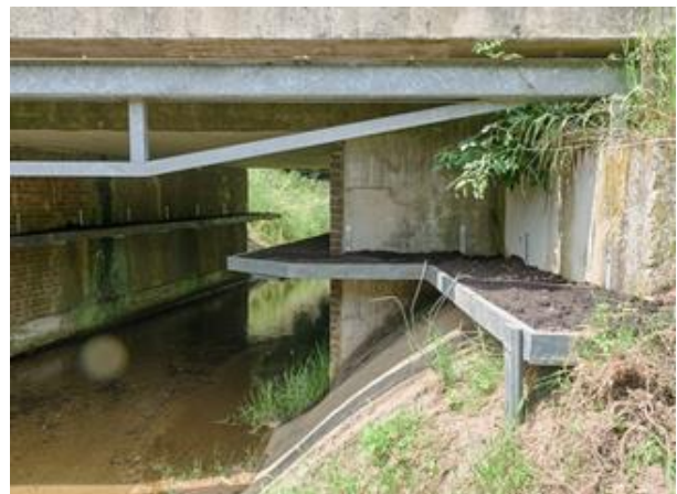
Geïnstalleerde looprichel in bestaande duiker
