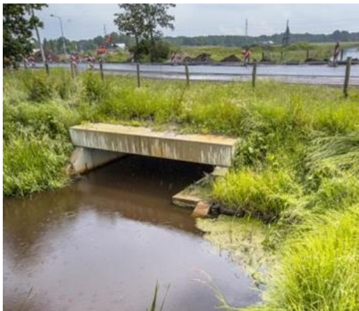
Betonnen loopzone in duiker
