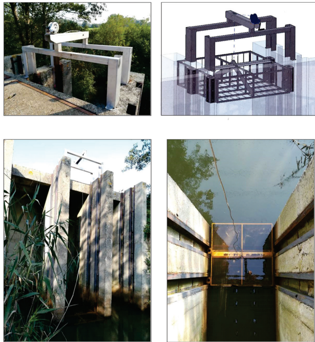
Figuur 7 – Het gemechaniseerd systeem met vangstkooien op de Molenbeek-Bollaak (Zandhoven) ter hoogte van het Albertkanaal (VMM).
