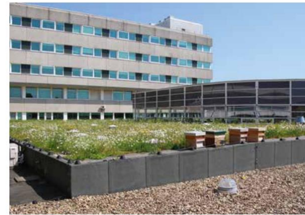
Het groene dak van ziekenhuis Rivierenland in Tiel.
