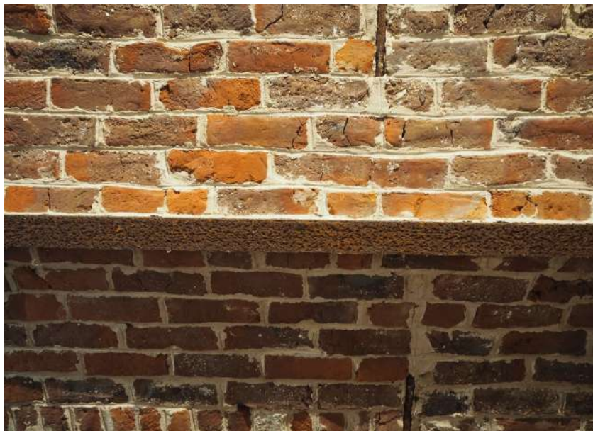
Afb. 71. Roestige I-liggers en trekstangen, onderdoorgang.
