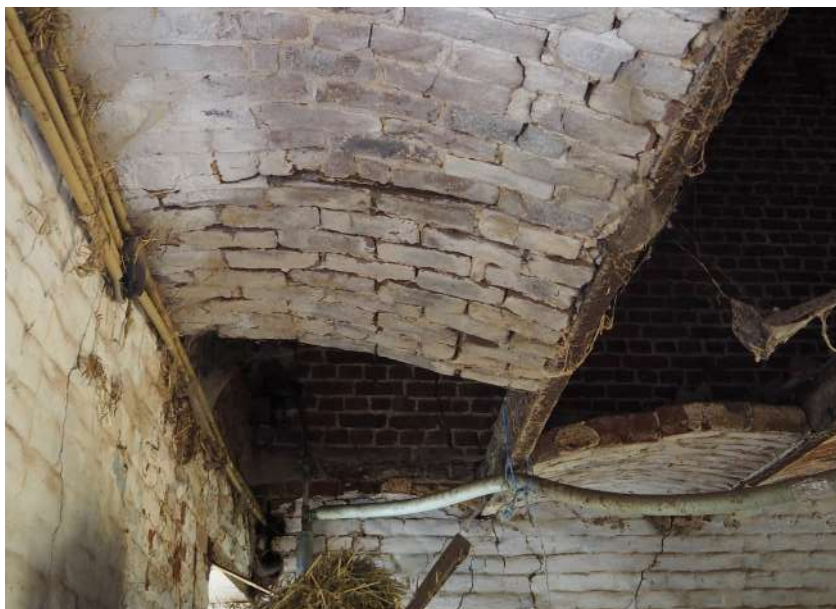
Afb. 75. Gebroken houten vloerlaag boven K0.04.
