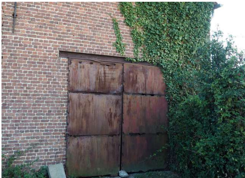
Afb. 94. Noordzijde gevel langsschuur. Verroeste deur.
