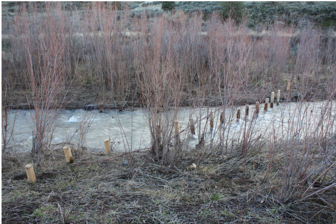
Figuur 1: Stimulatie beverdambouw door het aanbrengen van palen (Pollock et al., 2012)
