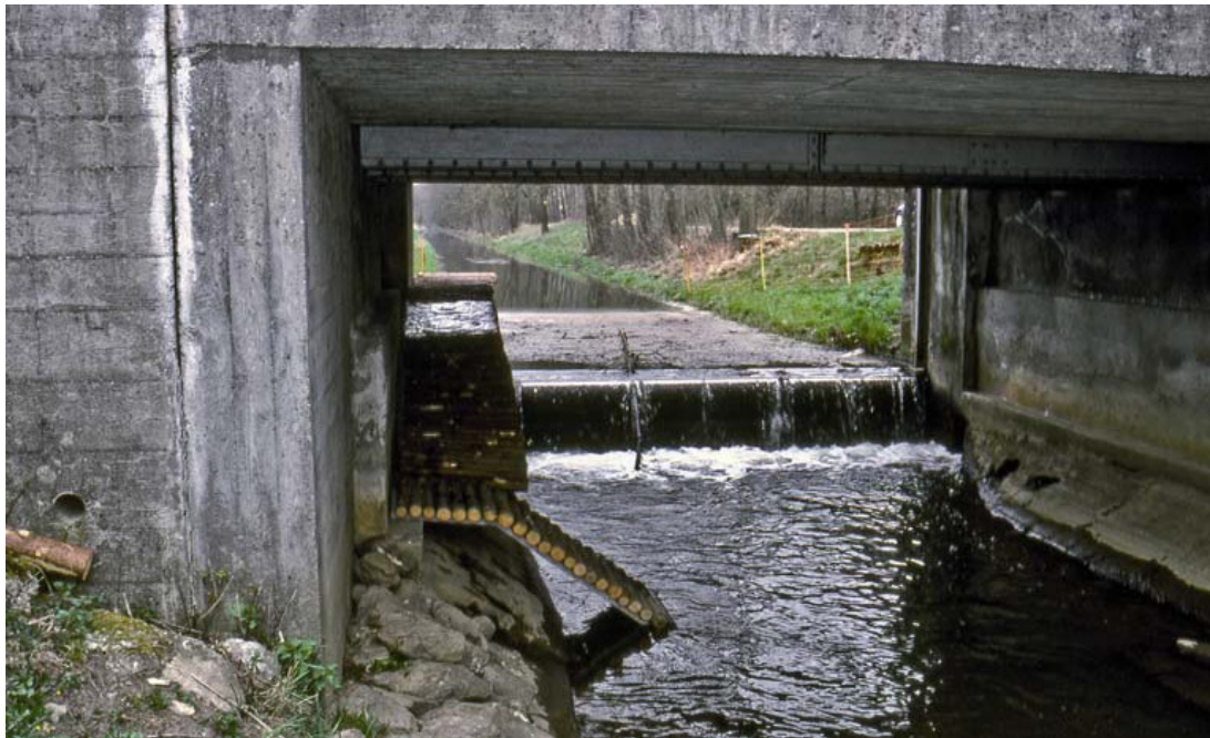
Figuur 2: Niet passeerbare stuw met passage (bron: BAFU, 2008 18 )
