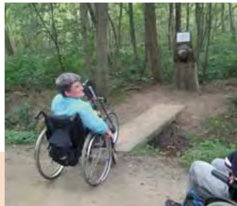
Deze brug is te smal (geen vrije doorgangsbreedte van 1,20m) en een leuning is noodzakelijk.
