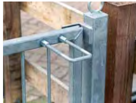
Detail kissing gate: handvat om poortje makkelijk te kunnen openen
