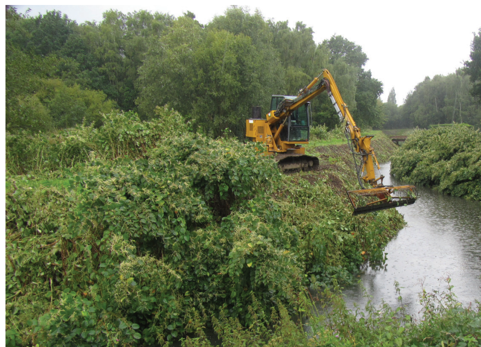
Ruiming van een waterloop met invasieve duizendknoop. Het geruimde materiaal wordt verderop gedeponeerd - © Sus Willems, ANB.
