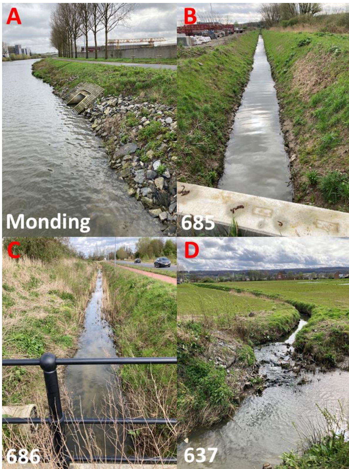
Figuur 2 - A : zicht op de nieuwe monding van OS366 in de Schelde. B : zicht op het afgeviste traject (locatie 685) stroomopwaarts van de monding in de Schelde en dus het nieuw gegraven tracé van OS366. C : zicht op het afgeviste traject (locatie 686) stroomafwaarts van de kruising van OS366 met de Stroomlaan. D : zicht op de samenvloeiing van OS366 en OS370. Het afgeviste traject (locatie 637) betreft een 15-tal meter stroomopwaarts vanaf de stroomversnelling zichtbaar op de foto.
