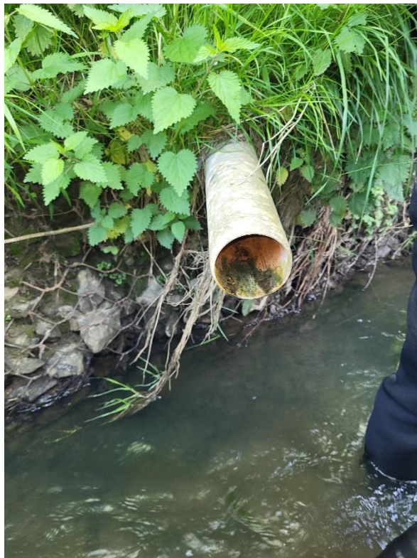
Figuur 16: Foto van de buis in de omgeving van monsternamepunt 372 waaruit mogelijk afvalwater komt.
