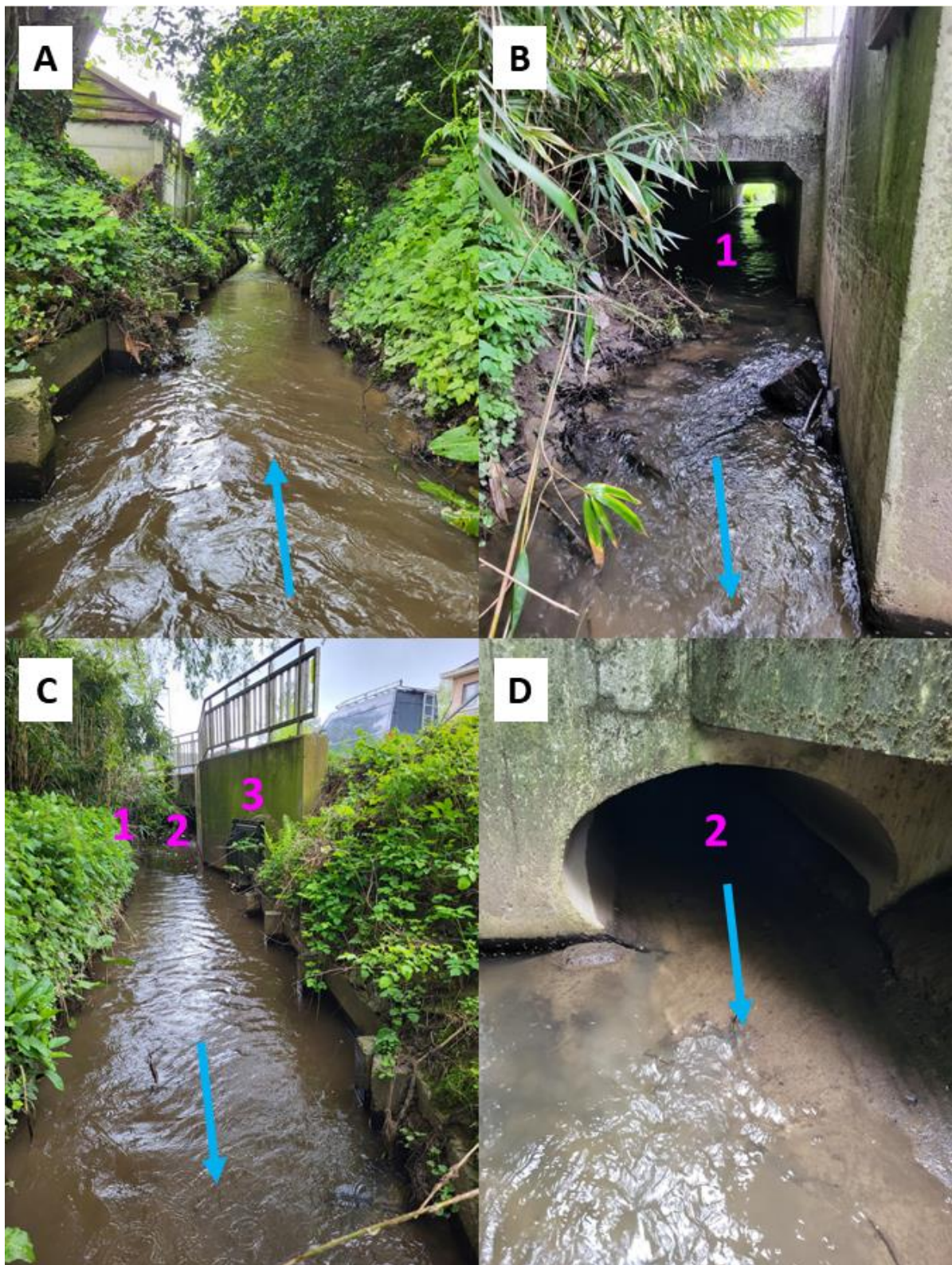
Figuur 2 – A: zicht (in stroomafwaartse richting vanaf de Kempinne-/Meetersstraat) van een deel van het afgeviste traject op locatie 700, B: Zicht (in stroomopwaartse richting) op de overwelving van de Kempinnestraat, deel van het afgeviste traject op locatie 700 C: Zicht op de situatie van de beek ter hoogte van de kruising met de Kempinnen-/Meetersstraat met de overwelving van de beek zelf (1), de monding van de Koudenbergbeek (2) en een overstort (3). D: zicht op de monding van de Koudenbergbeek in de Molenbeek-Graadbeek.
