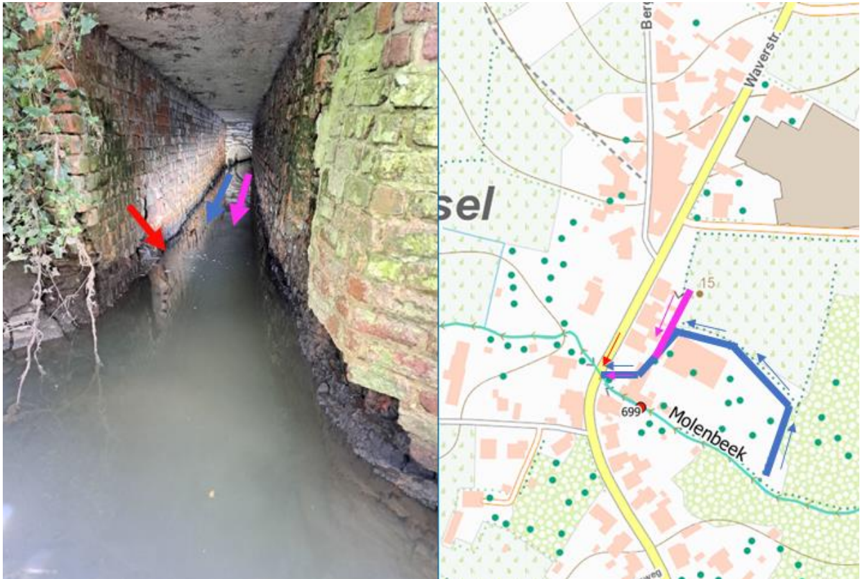
Figuur 14: Verduidelijking van de waterkundige situatie ter hoogte van de overwelving aan de kruising van de Waverstraat met de beek. De overwelving voert water van de Molenaarsgracht terug naar de beek (blauwe pijl, lokale ontduubelling van de beek). In de Molenaargracht komen echter via een lokale gracht (paarse lijn en pijlen) achterwaartse lozingen van grijs en zwart water van enkele huizen langs de Waverstraat terecht die bijgevolg ook in de beek belanden. De herkomst van het afvalwater dat werd opgemerkt in de kleinere koker (rode pijl) is momenteel onduidelijk.
